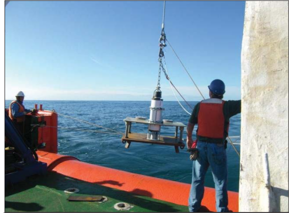
海底津波計の投入作業
