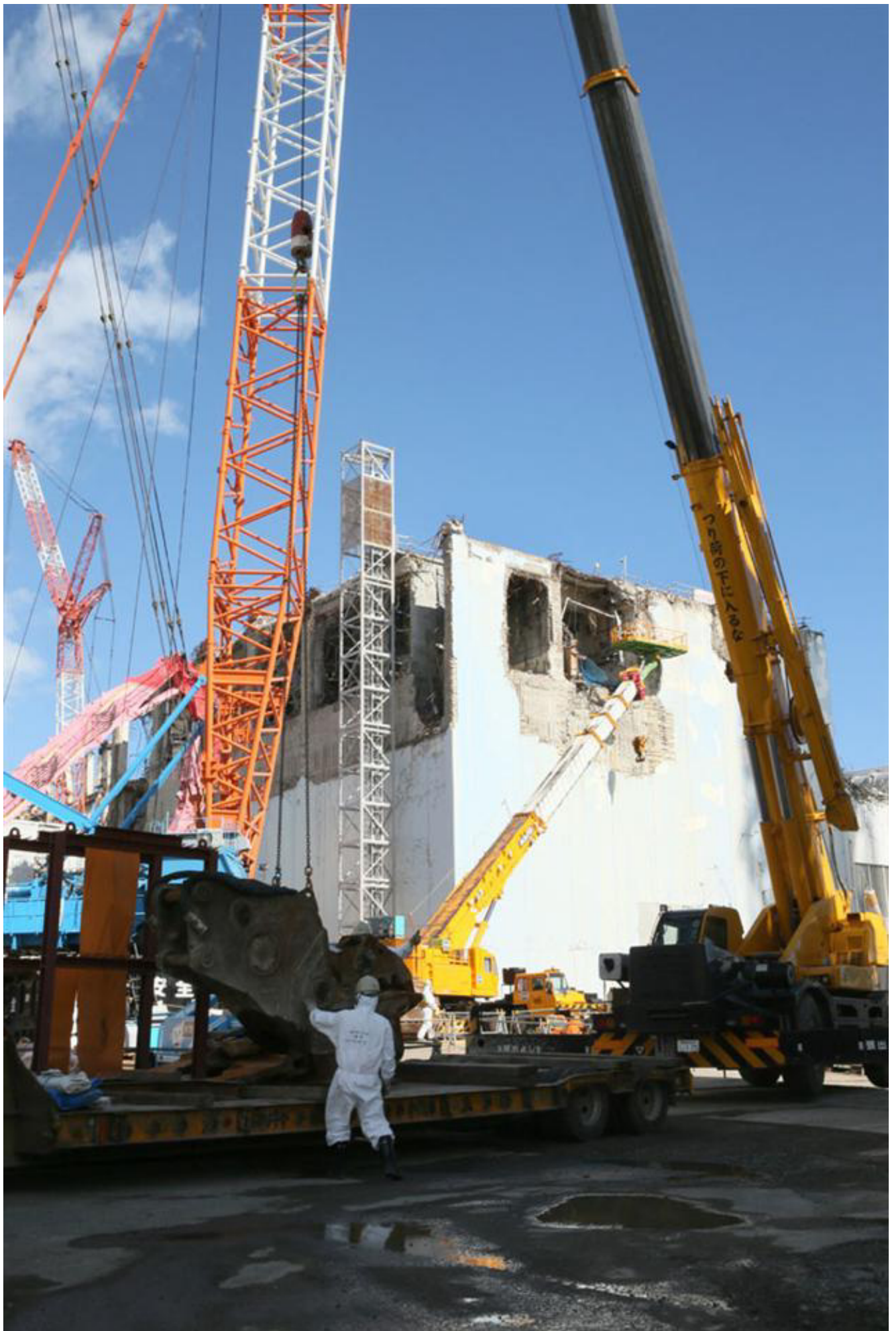
クレーンを使って瓦礫除去作業中の 4 号機の原子炉建屋=10 : 47
