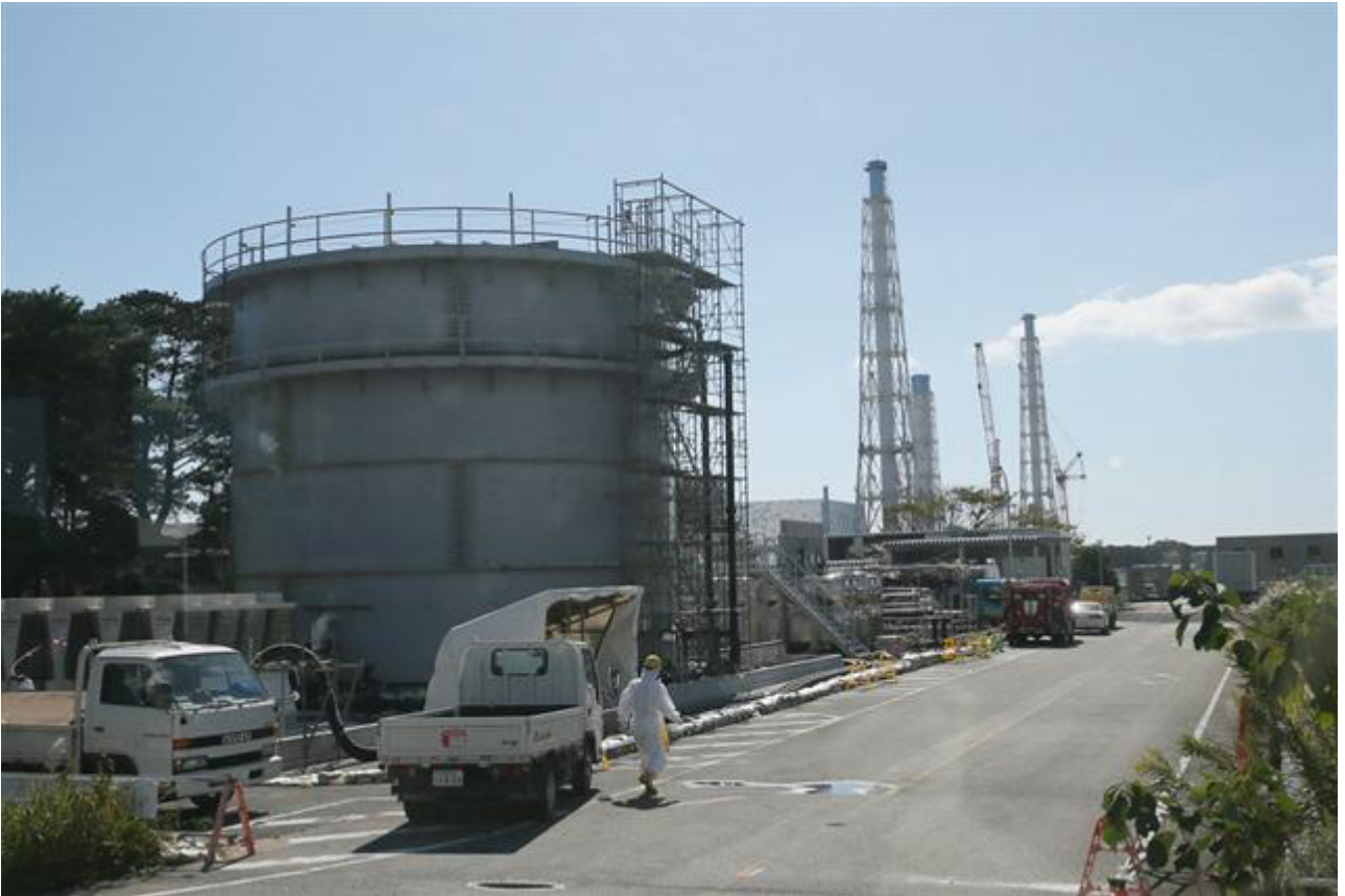
原子炉を冷やすための水が入るバッファタンク（左） 炉注水ポンプは右奥の車両の先にあるが見えない＝10：37
