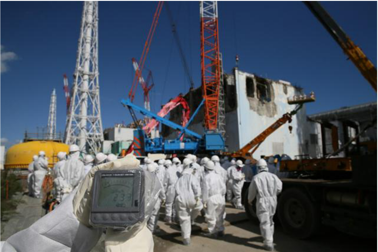
クレーンを使って瓦礫除去作業中の4号機の原子炉建屋＝10：56 230 \mu\text{Sv/h} を超える線量を計測
