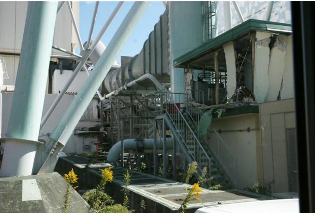
主排気筒の根元付近（中央）では昨年 8 月、10 Sv/h の高い放射線を検出＝11：10 1号機建屋と2号機建屋の間には「立ち入り禁止」の表示板が見えた
