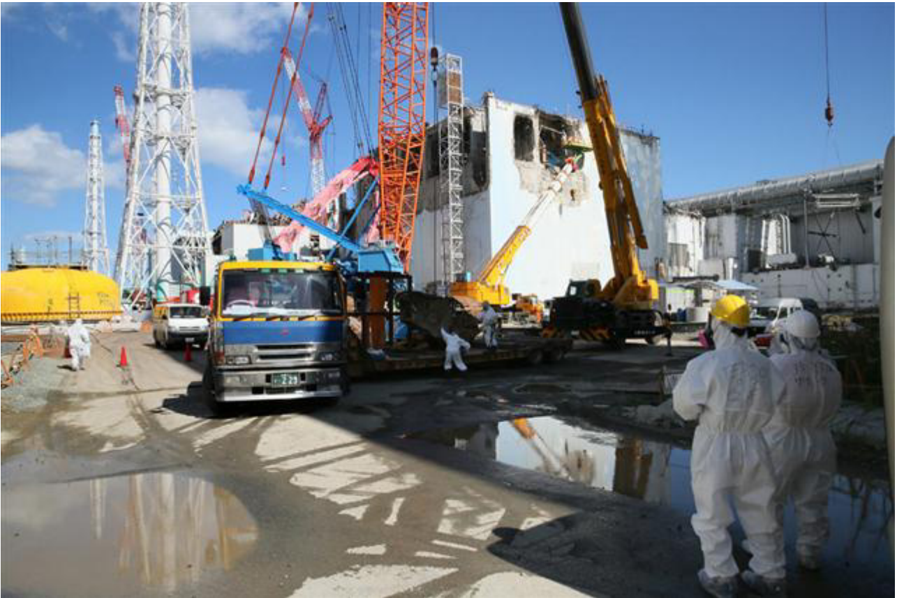
クレーンを使って瓦礫除去作業中の 4 号機原子炉建屋＝10：46
