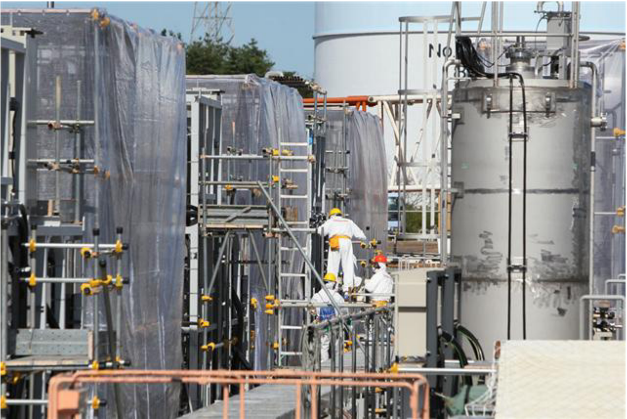
建設が進む「多核種除去設備」 = 11 : 16
