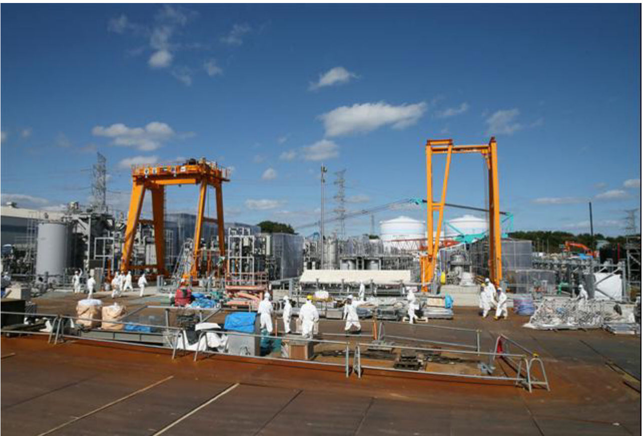
建設が進む「多核種除去設備」 = 11 : 22
