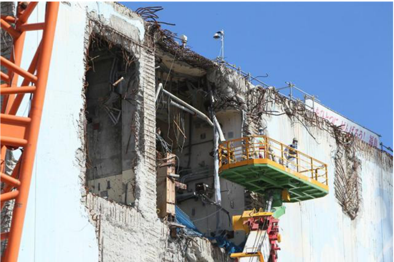
クレーンを使って瓦礫除去作業中の 4 号機の原子炉建屋＝10：50
