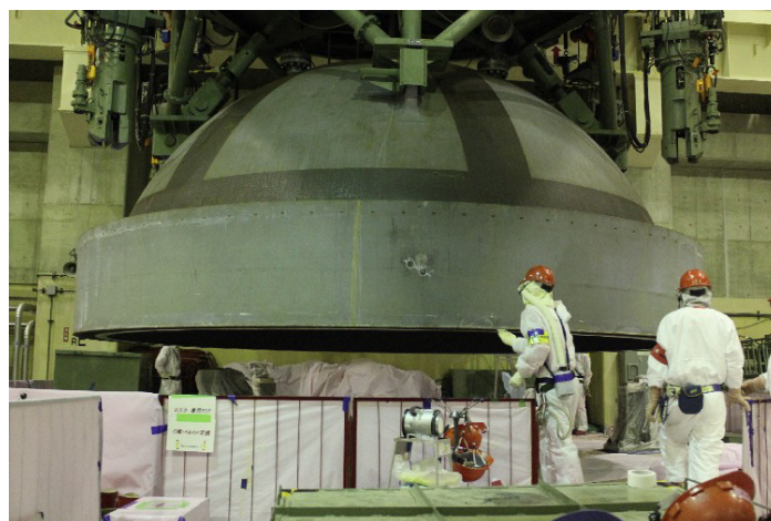
压力容器蓋取外し作業（2）
