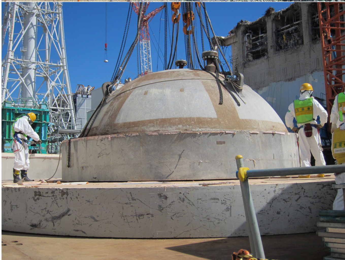
作業員：15人／班（2班体制） 被曝線量 [最大]：0.28mSv
