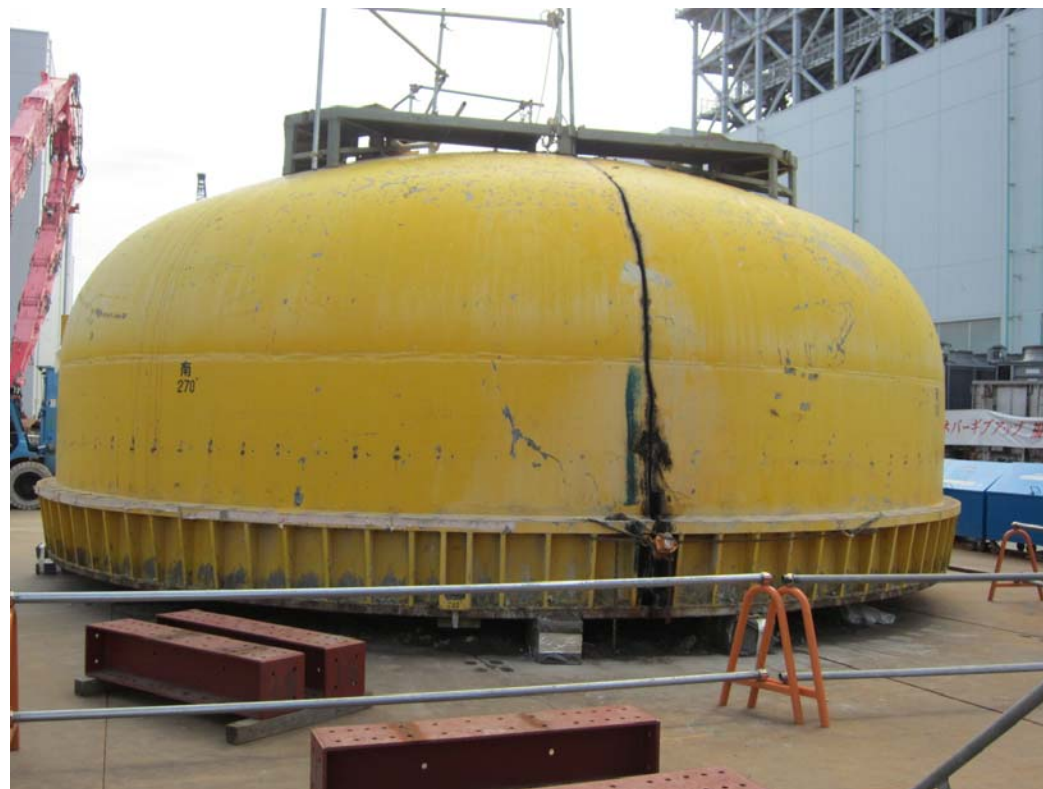
⑤-3 4号機格納容器蓋（切断後） 平成24年9月5日 当社社員撮影
