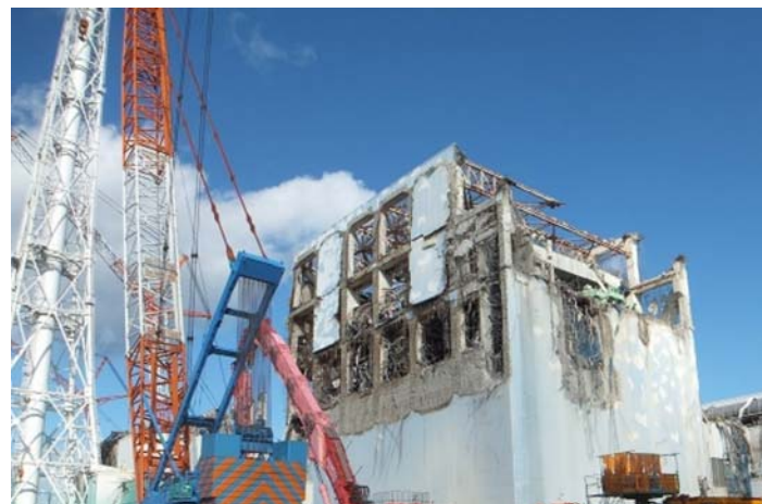
④-2 4号機原子炉建屋上部ガレキ撤去（作業中） 平成24年1月5日 当社社員撮影
