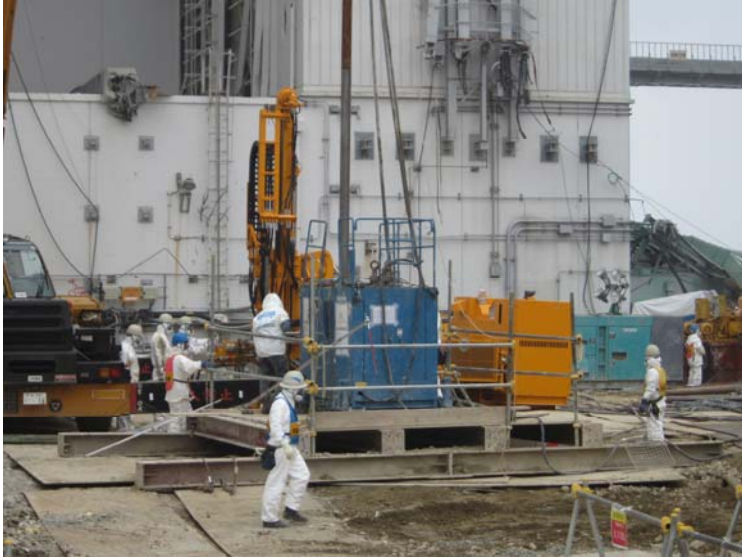
⑥-1 4号機南側地盤改良工事 地盤改良機 平成24年6月7日 当社社員撮影
