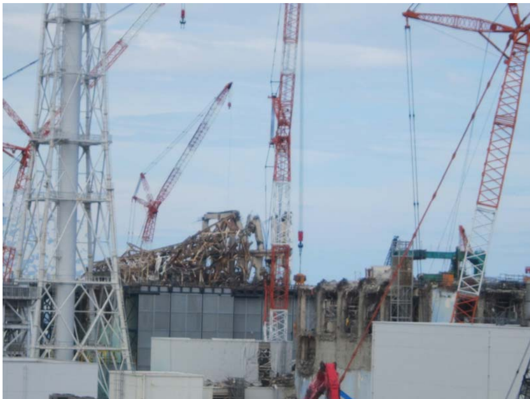
①-1 3～4号機外観（南高台より） 平成24年9月5日 当社社員撮影
