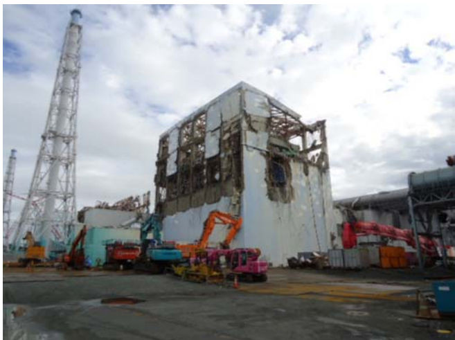
④-1 4号機原子炉建屋上部ガレキ撤去（作業前） 平成23年9月22日 当社社員撮影
