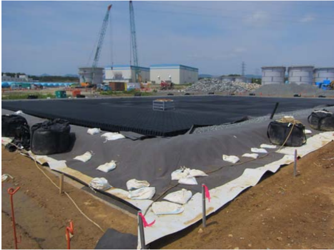
⑧-1 地下貯水槽設置工事 平成24年6月18日 当社社員撮影
