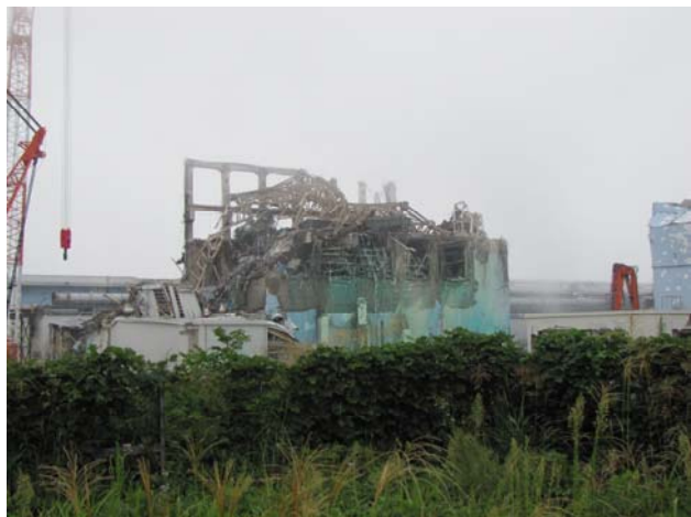
③-1 3号機原子炉建屋上部（ガレキ撤去作業前） 平成23年9月15日 当社社員撮影
