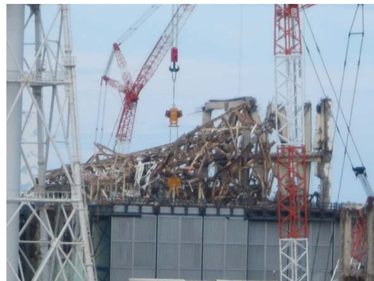
①-2 3号機外観（南高台より） 平成24年9月5日 当社社員撮影
