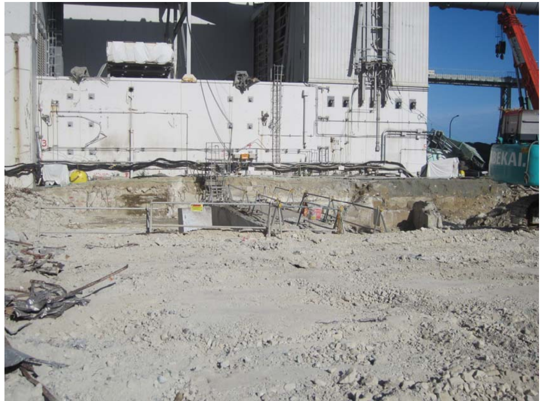
⑥-2 4号機南側地盤改良工事（完了後） 平成24年9月3日 当社社員撮影
