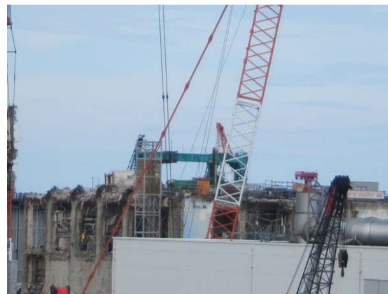
①-3 4号機外観（南高台より） 平成24年9月5日 当社社員撮影
