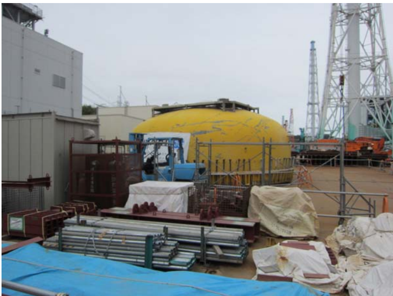
⑤-1 4号機格納容器蓋 平成24年8月15日 当社社員撮影
