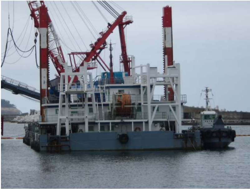
⑨ 遮水壁杭打ち船 平成24年8月15日 当社社員撮影
