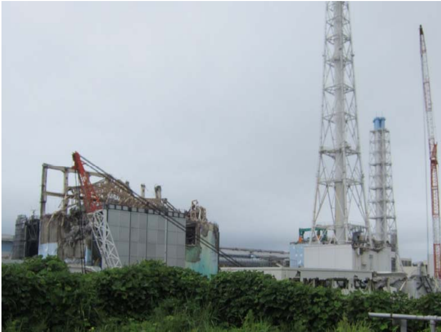
②-1 3、4号機外観 (2、3号機間山側高台より) 平成24年8月15日 当社社員撮影
