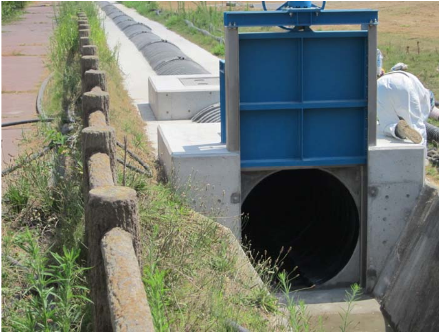
⑪ 構内排水路（PE管）設置状況 平成24年8月21日 当社社員撮影
