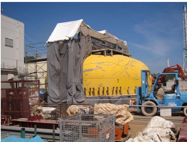
⑤-2 4号機格納容器蓋（切断風景） 平成24年8月27日 当社社員撮影
