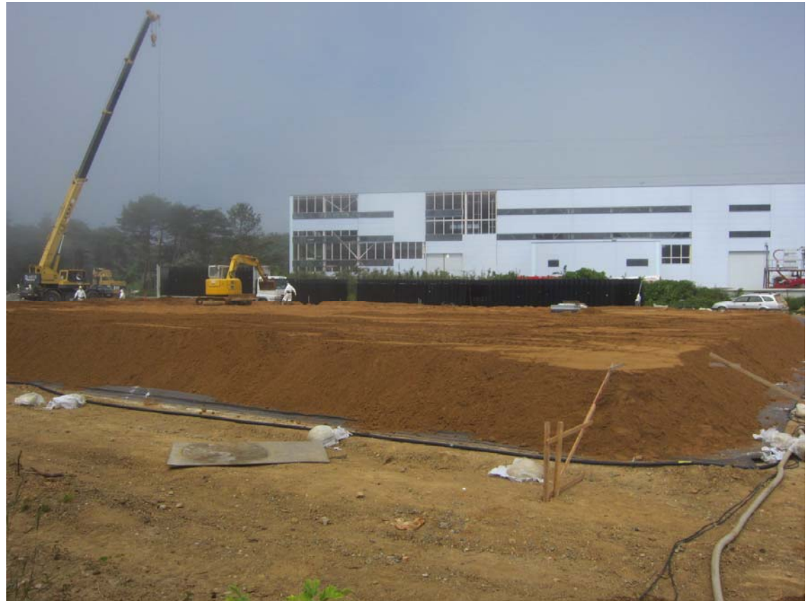
⑧-2 地下貯水槽設置工事 平成24年8月21日 当社社員撮影
