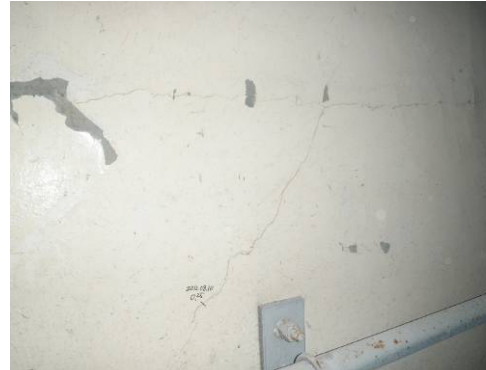
② 2階 西3-西4間外壁内面 (ひび割れ幅 0.3mm)
