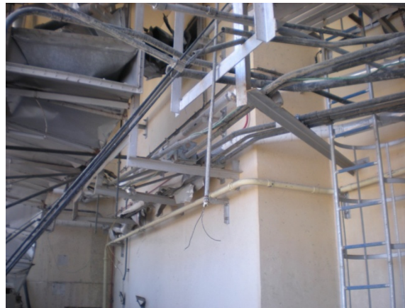
⑨ SFP側壁面（東側）
