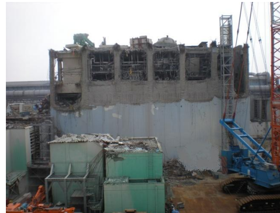
⑤ 西面（外壁）
