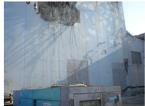
⑥ 南面（外壁）
