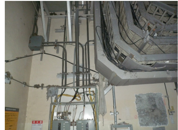
④ 西面（内壁）
