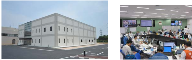
免震重要棟(左:外観、右:緊急対策本部)
