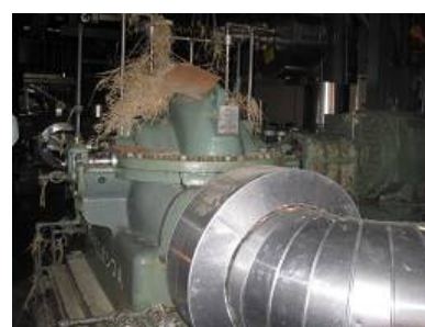
被水した1号機残留熱除去海水系 中間ループ循環ポンプ
