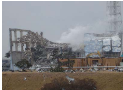
4 号機損傷状況（写真右） （写真左は 3 号機）
