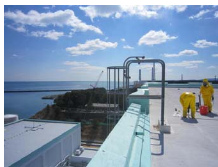
屋上での作業状況
