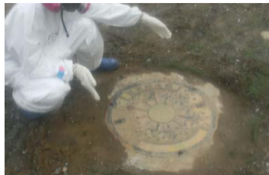
防火水槽の取水蓋
