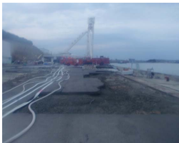
物揚場からの消防車による注水
