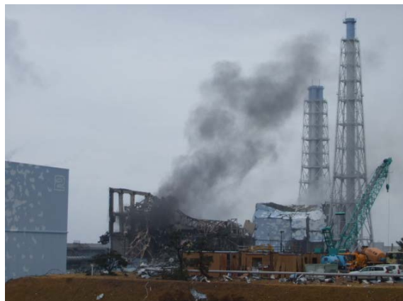
爆発後の3号機の外観 (撮影日：H23.3.21)
