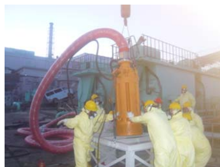
水中ポンプ設置作業の状況
