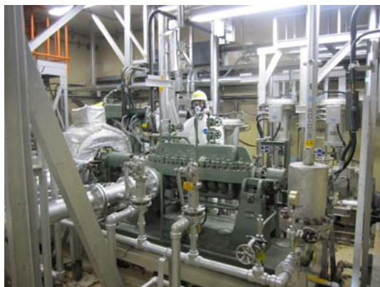
RCIC (5号機 照明あり)
