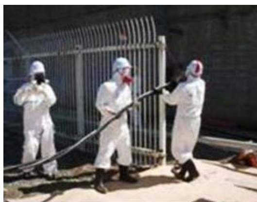
ケーブル敷設作業のイメージ
