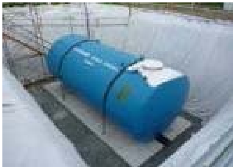
埋設の防火水槽（設置時のもの）
