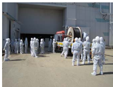
仮設ケーブル敷設準備 (作業状況は後日のもの)
