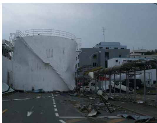
津波で流されて道をふさいだ重油タンク (直径11.7m×高さ9.2m)
