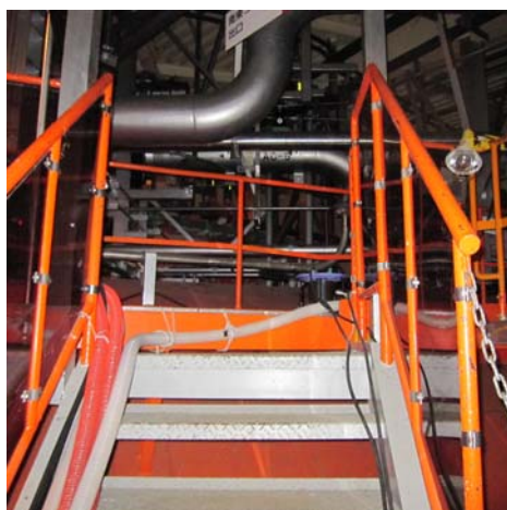
トーラス室入口（5号機 照明あり）
