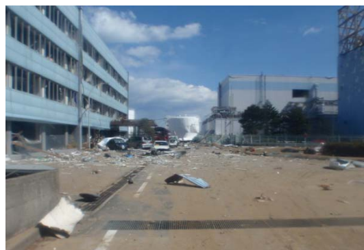
爆風により窓ガラスが割れた旧事務本館 (右端が1号機)
