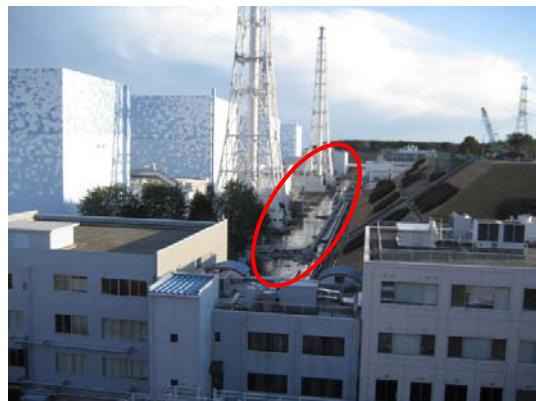
津波により1~4号機全域が浸水
