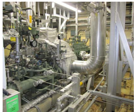
RCIC (5号機 照明あり)
