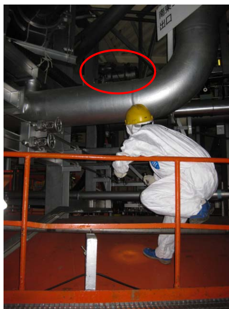
S/C ベント弁確認作業イメージ
