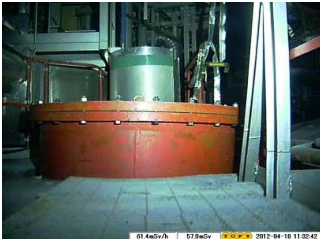
【トーラス室南東側 S/C マンホール】
