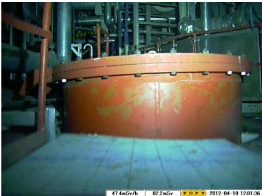
【トーラス室北側 S/C マンホール】
