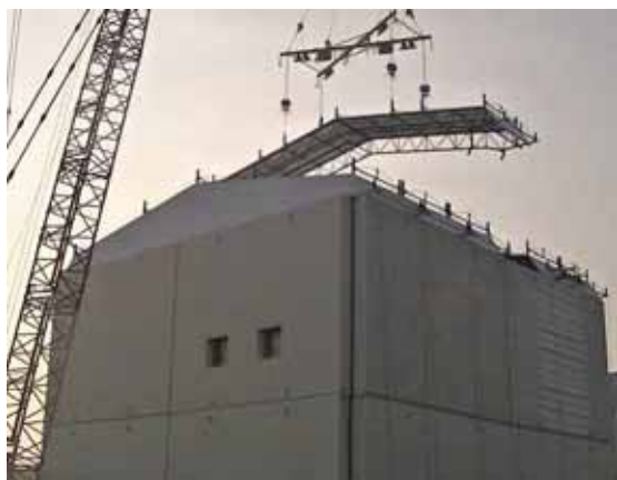
写真 13. 建屋カバー屋根パネル設置 (平成 23 年 10 月 14 日撮影)
