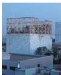
写真28. 爆発後の1号機原子炉建屋 (平成23年3月12日撮影)
