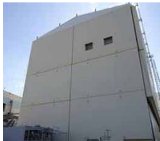
写真 14. 建屋カバー竣工 (平成 23 年 10 月 28 日撮影)
