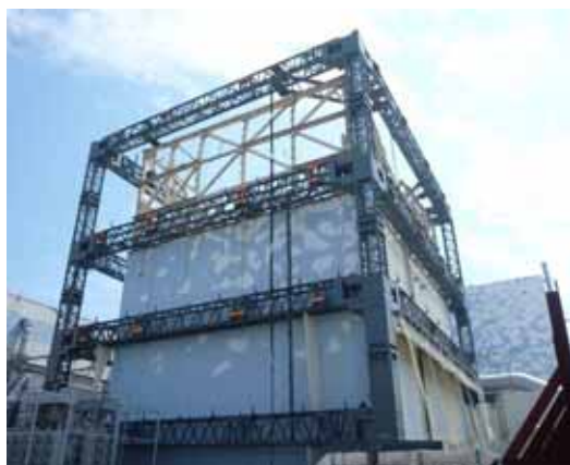
写真11. 建屋カバー鉄骨建方完了 （平成23年9月9日撮影）
