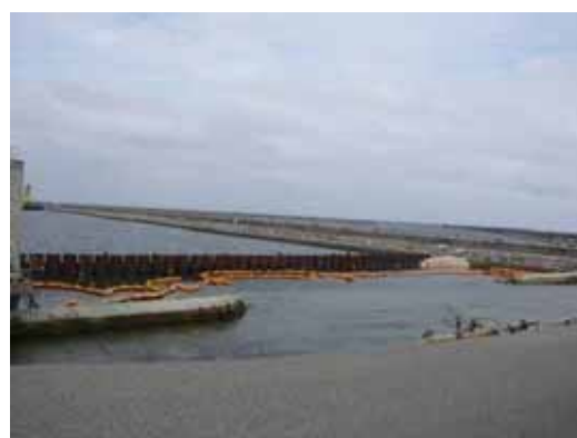
写真17. 福島第一原子力発電所1～4号機取水路開渠南側透過防止工復旧工事 (平成23年9月28日撮影)
