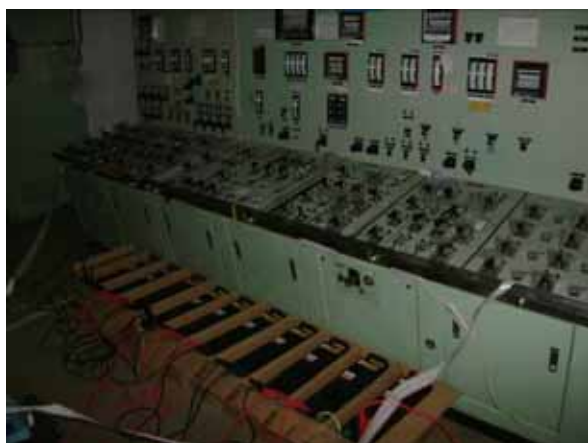
写真 6. 仮設バッテリーをつないで計器用電源として使用 (平成 23 年 3 月 15 日撮影)
