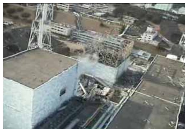
写真5. 福島第一原子力発電所1号機、2号機 —写真手前から2号機、1号機。左側が原子炉建屋、 右側がタービン建屋。 （平成23年3月11日撮影）
