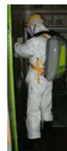
写真26. セルフエアセット （平成23年5月4日撮影）
