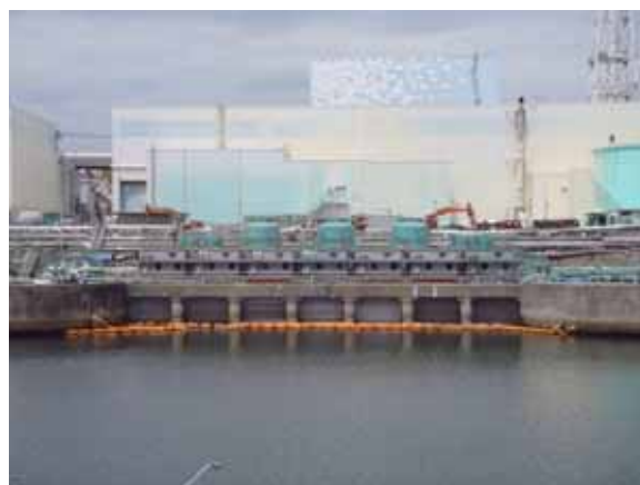
写真16. 2号機取水口仕切り板 (平成23年6月30日撮影)
