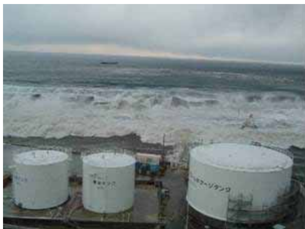
写真2. 福島第一原子力発電所 津波来襲状況 5号機の近傍（南側）から東側を撮影 （平成23年3月11日撮影）
