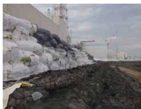
写真 19. 仮設防潮堤（平成23年6月30日撮影）
