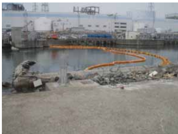
写真15. シルトフェンスの設置 (平成23年4月10日撮影)
