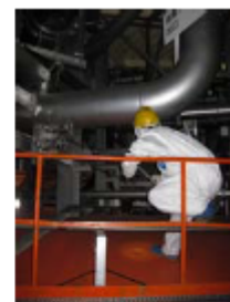
写真27. ベント弁確認作業イメージ
