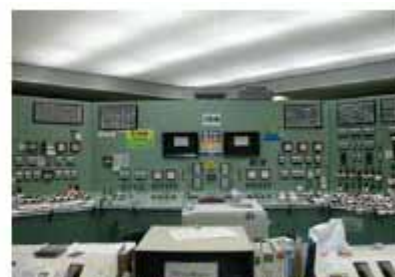
写真25. 中央制御室の照明復旧（4号機） （平成23年3月29日撮影）
