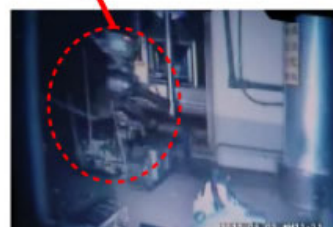
1号機タービン建屋内高線量箇所 調査時の様子(8月2日)
