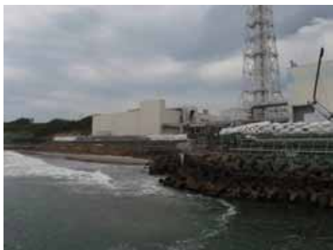
写真 18. 仮設防潮堤（平成23年6月30日撮影）
