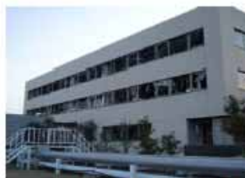
写真29. 爆風により窓ガラスが割れた事務本館 (平成23年3月19日撮影)
