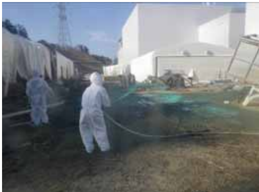
写真9. 飛散防止剤散布（平成23年4月1日撮影）
