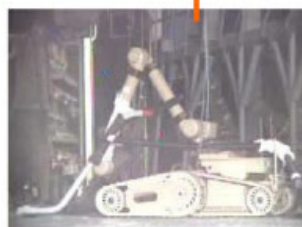
3号機原子炉建屋内清掃作業の様子 (7月1日)
