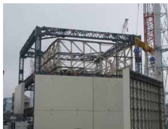
写真12. 建屋カバー壁パネル設置状況 （平成23年9月15日撮影）
