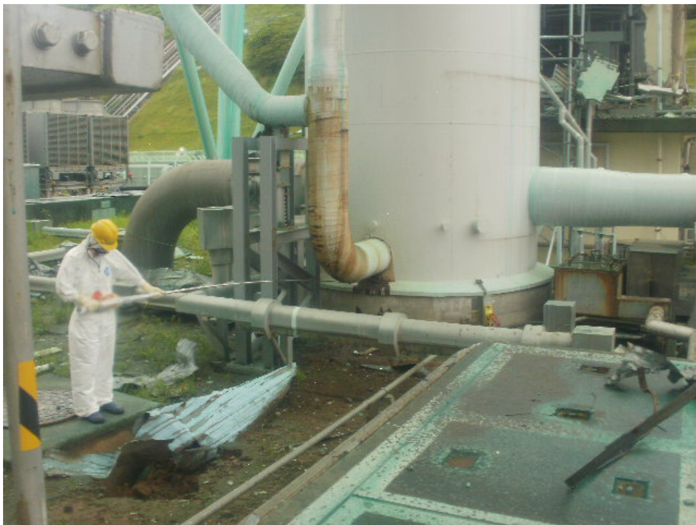
1F・1・2号機主排気筒底部 非常用ガス処理系配管接合部付近 撮影日：2011年8月1日 = 東電提供
