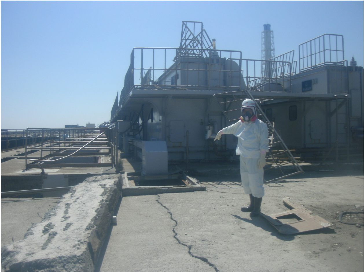
1F-2号機取水口付近 4月1日 撮影=東電提供
