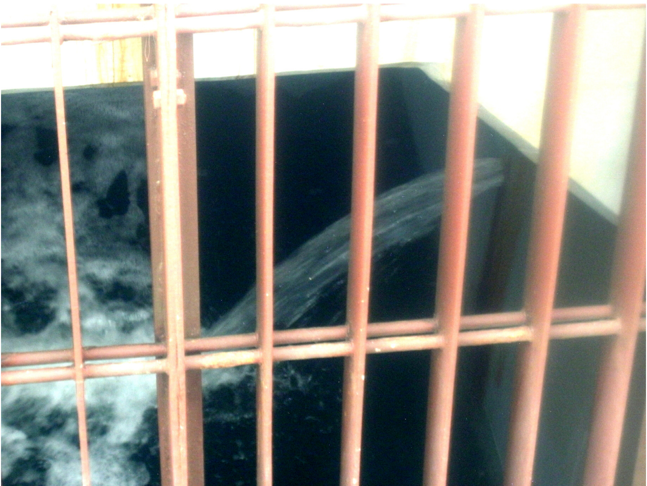
1F-2号機取水口脇ピット 4月2日 撮影=東電提供
