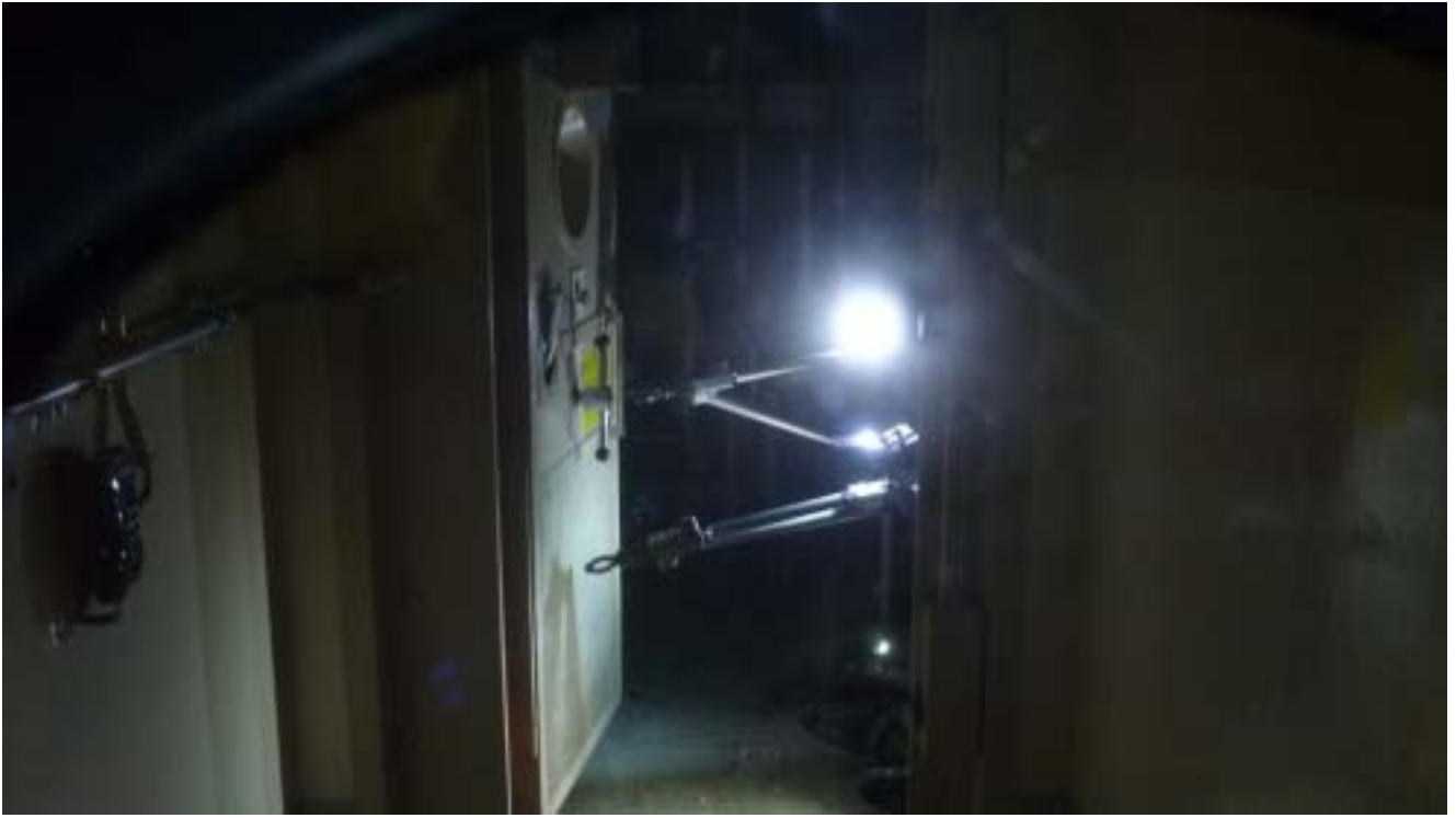
1F - 3号機原子炉建屋内 米国 iRobot 社製の遠隔操作ロボット「Packbot」作業
