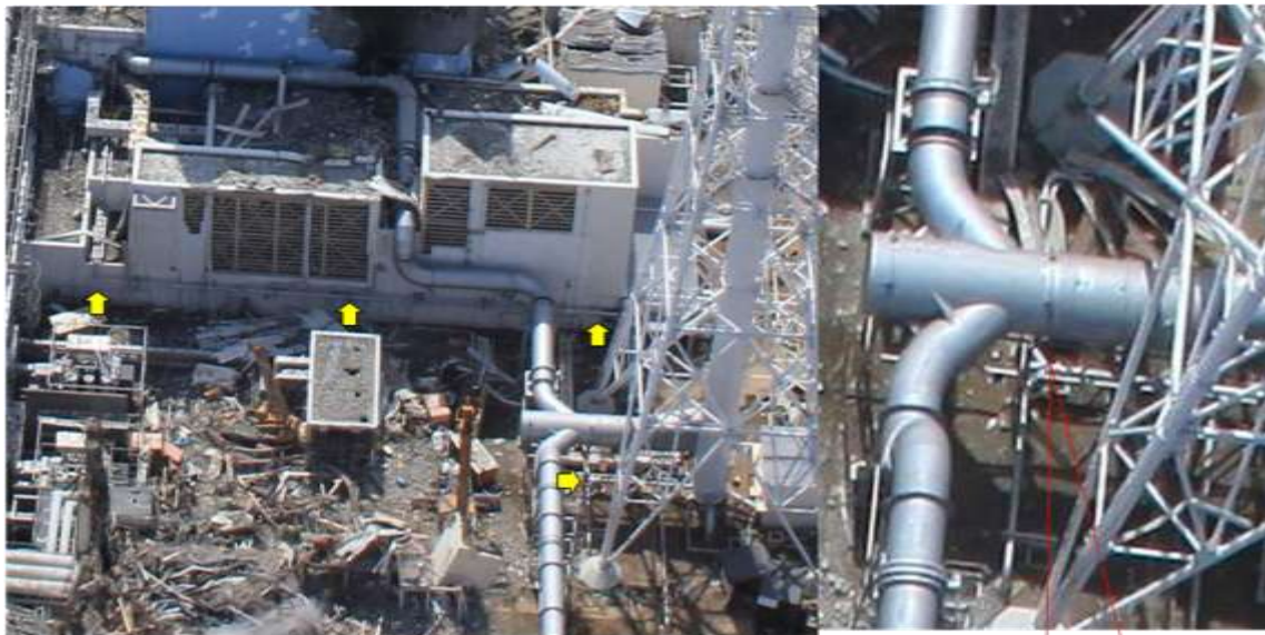
図IV-5-10 3号機から4号機への水素の流入経路（推定）
